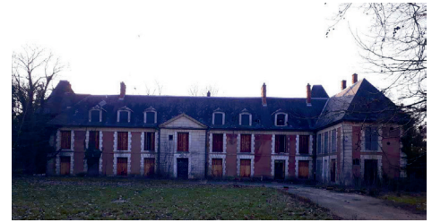
État actuel de la façade sud
