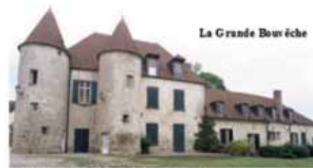
Salle de conférence ↑ au 1er étage : entrée par la tour
